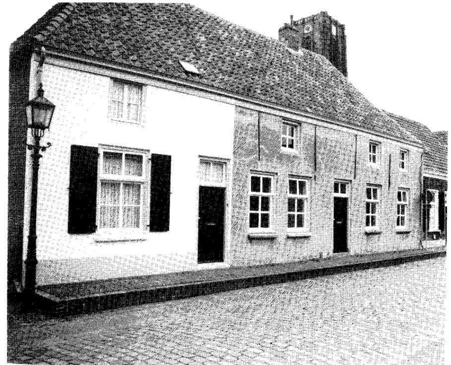
Nieuwstraat 13 (links) en 15.
