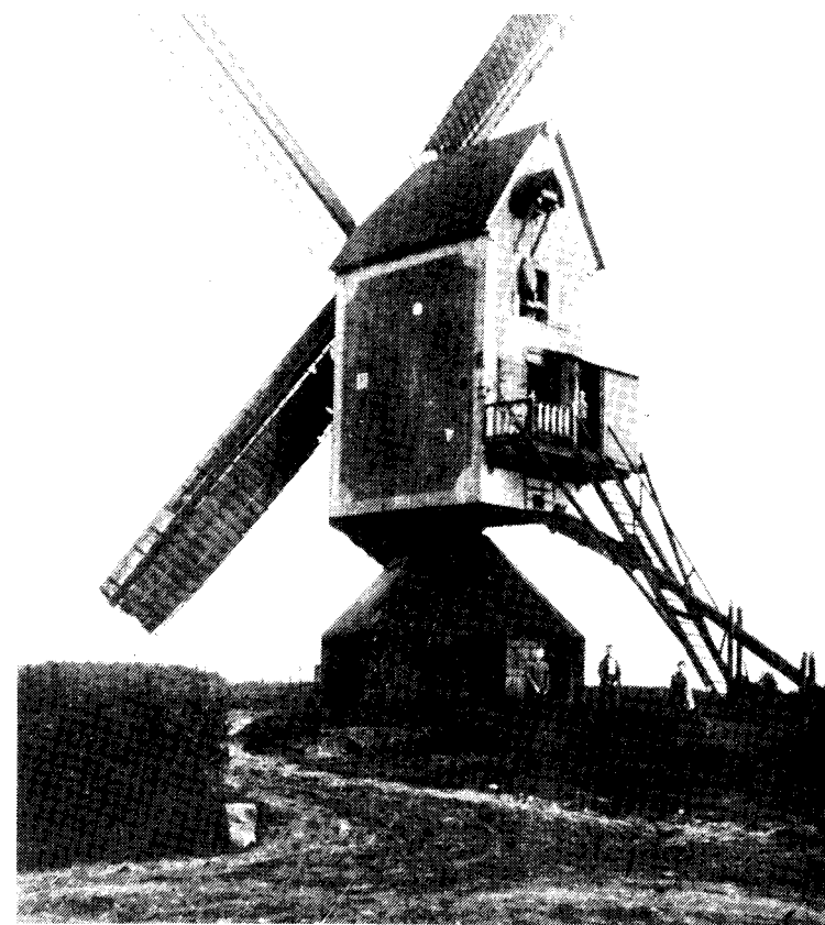
De standermolen van Oerle, gefotografeerd op zijn laatste standplaats aan de Zandoerleseweg. De foto is gemaakt in 1932, het jaar waarin met de sloop werd begonnen.
