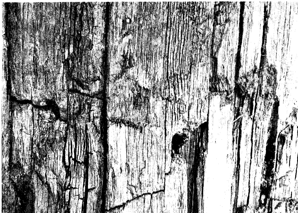
Detail van de putwand, met daarin de twee gaten
